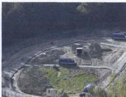
L'area del cantiere di Chiomonte
