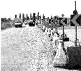
Un cantiere aperto lungo la Paullese
