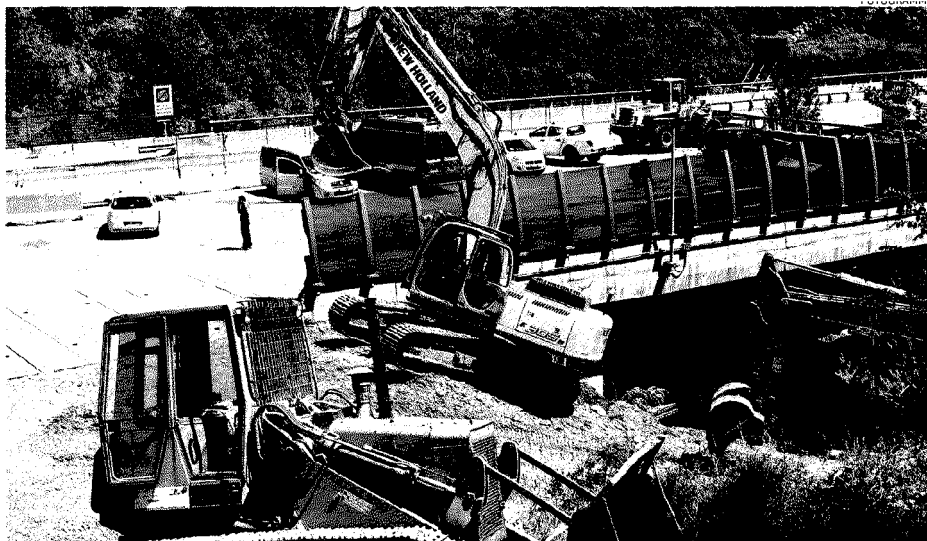
All'opera. I primi lavori, la settimana scorsa, al cantiere della Maddalena di Chiomonte
