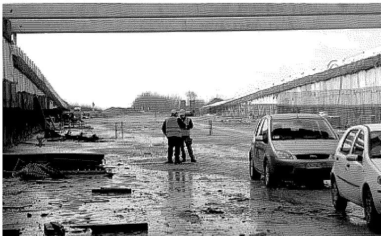
INFINITO Il cantiere che doveva unire lo svincolo di Lambrate alla città di Pioltello è fermo per l'innalzamento delle falde acquifere
